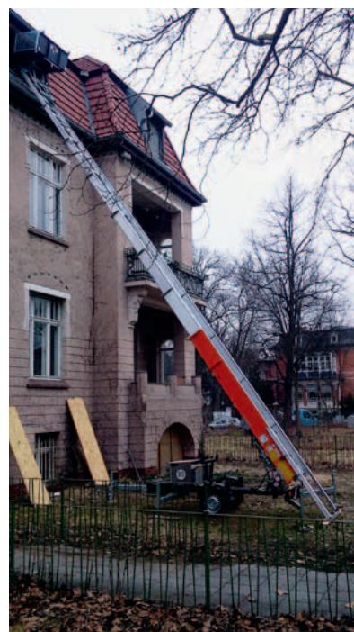
Junior Bauaufzug im Einsatz
