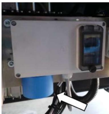
Abb. 15-3 Einspeisung 230 V/0,9 kW/50Hz für Ladegerät LI Ionen Batteriesystem
