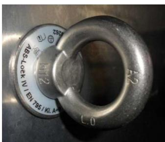
Abb. 11-11 Anschlagpunkt für Rückhaltesystem
