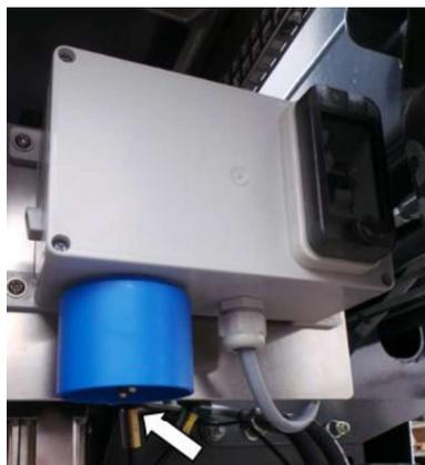
Abb. 11-1 Einspeisung für Steckdose
